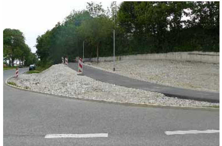
Erfolgreich entschärft: Radweg-Einmündung an der Herzog-Albrecht-Straße
