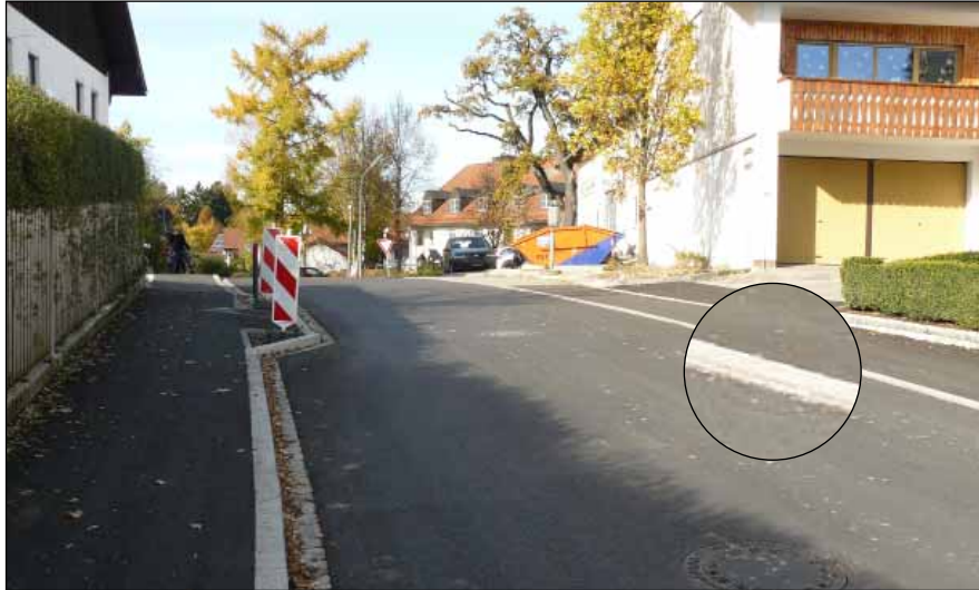
Das Foto zeigt eine der kritischen Stellen, wo die Torwirkung der Fahrbahneinengung durch den abgesenkten Bordstein ihrer Wirkung beraubt wird.
