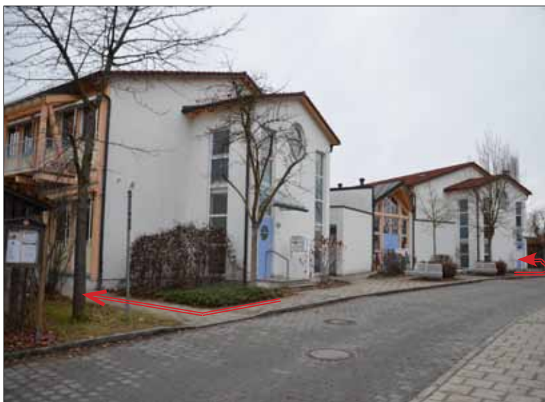
Links: Eingang BRK-Raum, rechts um die Ecke: Eingang zum Hauptraum
