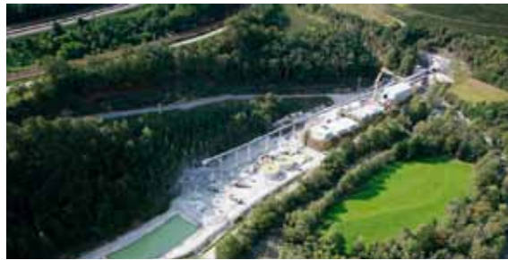
Es wird schon gebaut: Baustelle bei Franzensfeste
