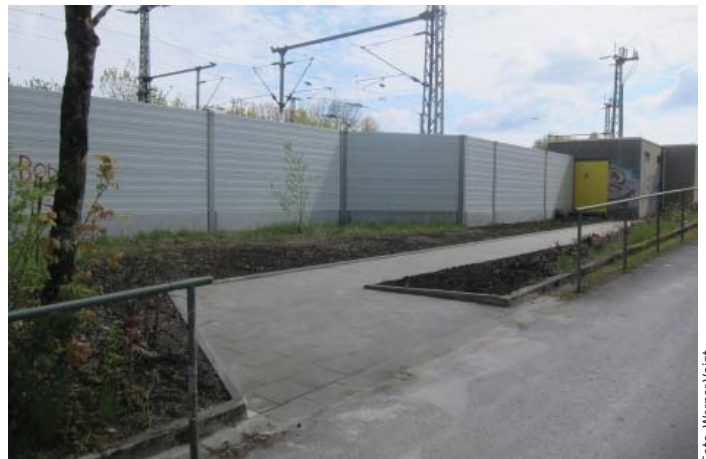
Die neue, waagrechte Verbindung zwischen Rampe und Parkplatz
