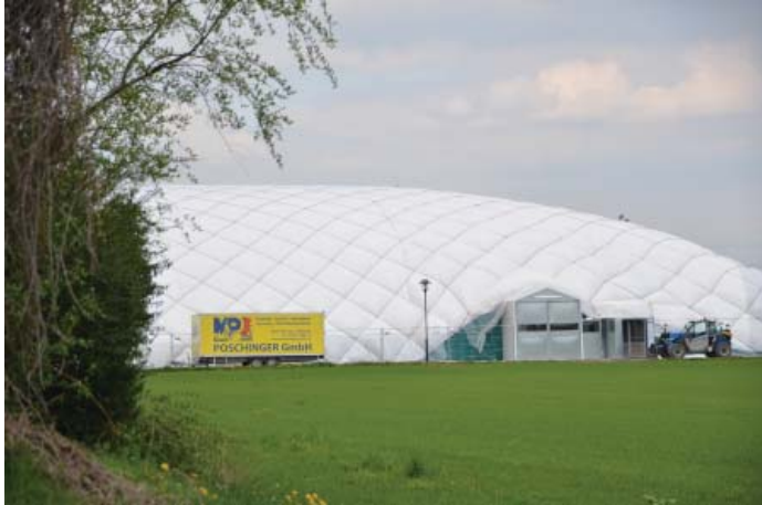
Die Traglufthalle in Pliening
