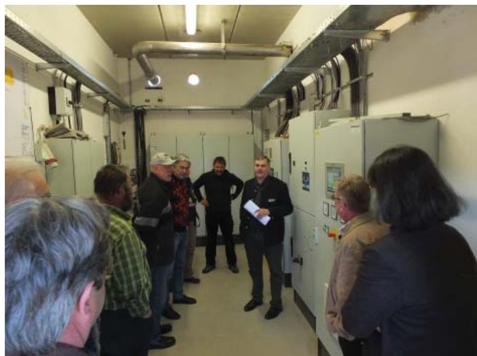
Die Motorsteuerung für die beiden Generatoren
