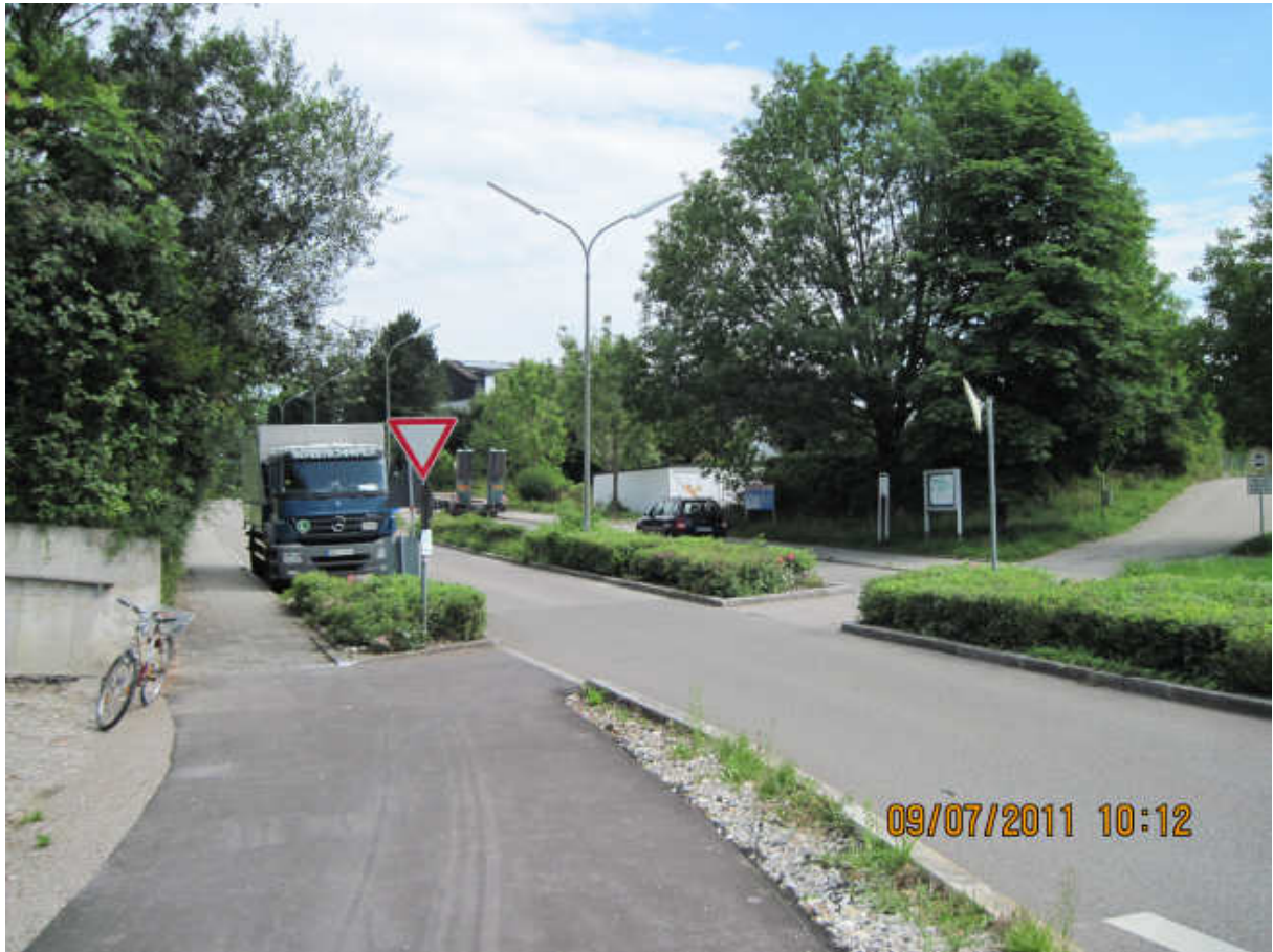
Einmündung Geh- und Radweg an der Herzog-Albrecht-Straße nach Umbau
